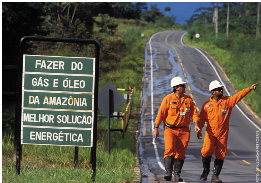
Werknemers van Petrobras bij de aanleg van de pijpleiding tussen de Urucuvelden en Manaus. Op het bord staat: 'Gas- en oliewinning in het Amazonegebied is de beste energieoplossing'.
