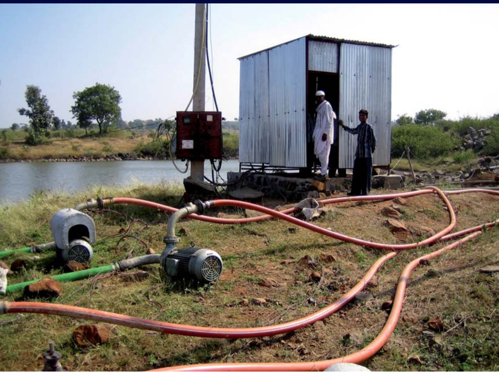
Linksboven: elektrische pompen met transformator in het Bibkhed-irrigatiesysteem.
