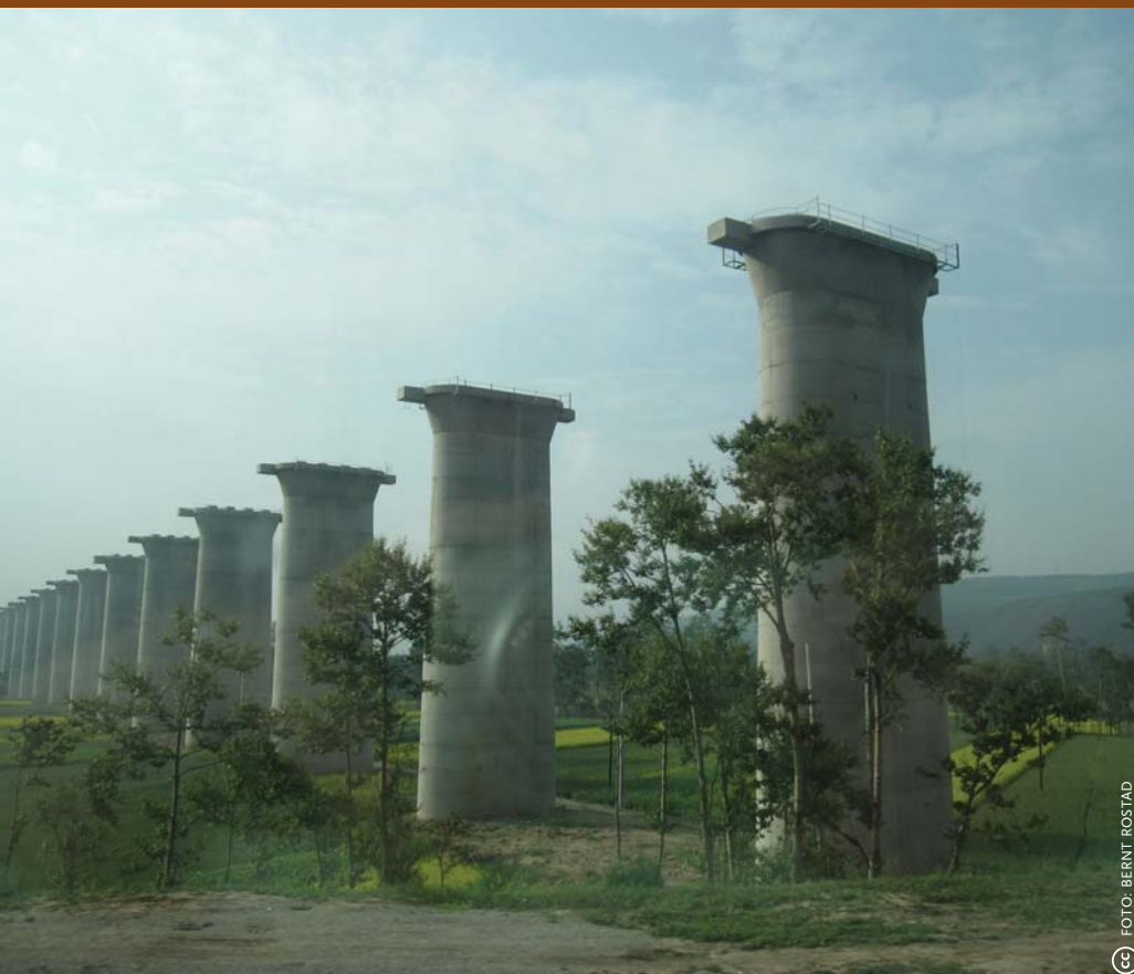
Pylonen van een HSL-spoorverbinding naar Xining, hoofdstad van de provincie Qinghai.
