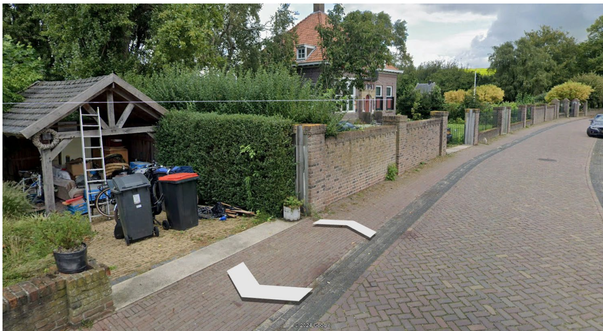
Figuur 11 Roestvrijstalen gleuven voor schotbalksysteem Empelse dijk
