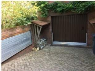
Figuur 12 Roestvrijstaal schotbalksysteem
