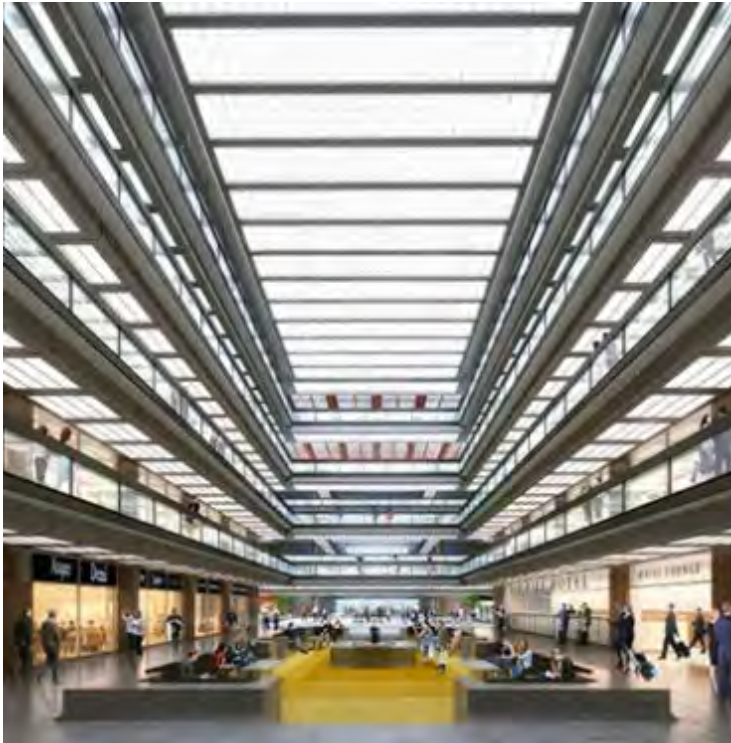
Dakvenster van 5575 m 2 met 20% transparantie in het voormalige Bell Building door Onyx Solar
