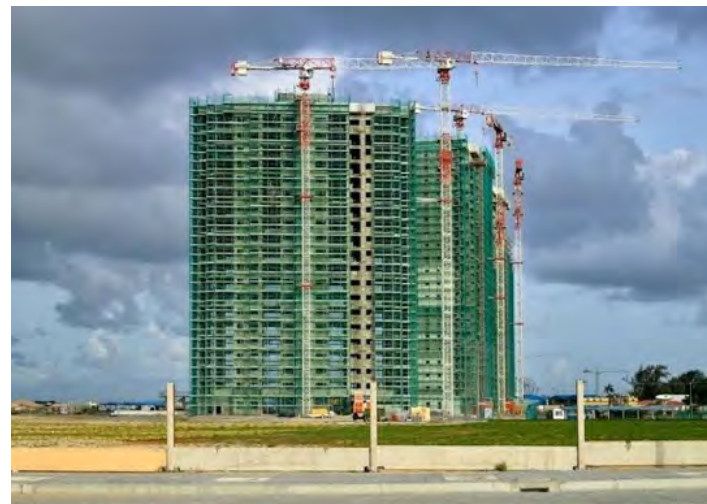
Bouwwerkzaamheden Eko-Atlantic City - Photo Trenzbase (CC)
