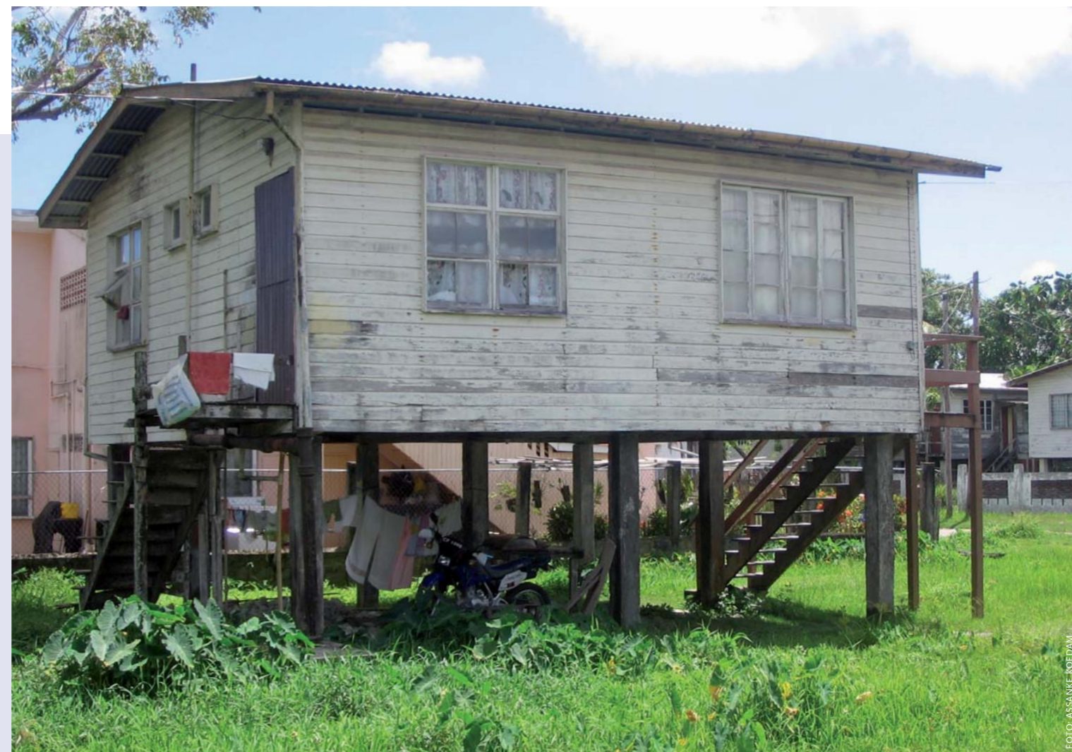
Veel inwoners van North Ruimveldt wonen in zelfgebouwde, traditionele huizen op palen, die bescherming bieden tegen de talrijke overstromingen.
