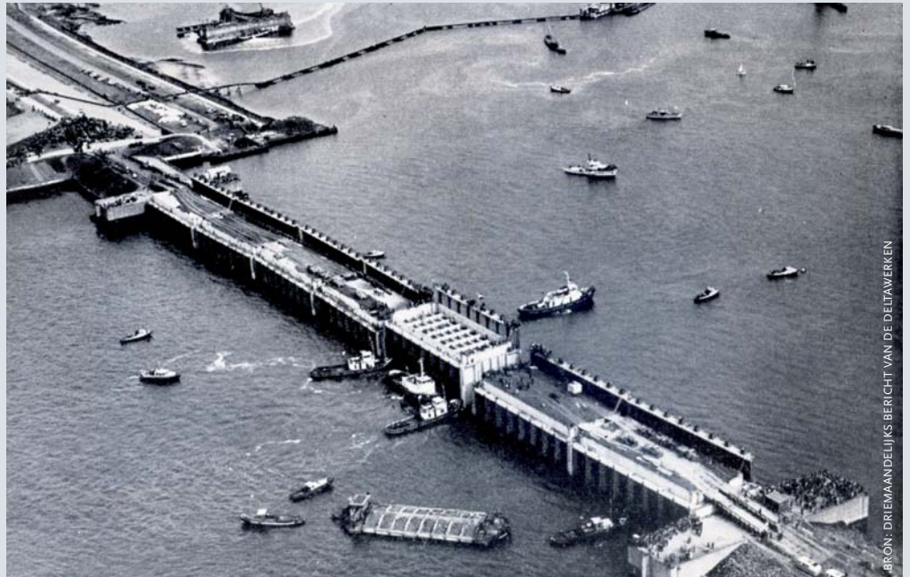
Het officiële moment van de plaatsing van het laatste caisson en de afsluiting van het Veersche Gat.
