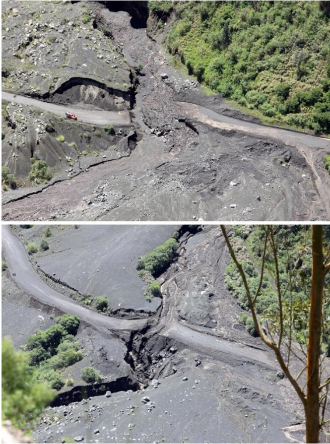
Figuur 11. Schade aan wegen door lahars vanaf de hellingen van de Tungurahua veroorzaakt door regenval. Boven: een verwoeste weg door een lahar uit de Chontapamba kloof. Let op de geïsoleerde auto. Mei 2014. Onder: een lahar uit de Chontapamba kloof vernielde een hoofdweg op twee plaatsen. Mei 2014.
